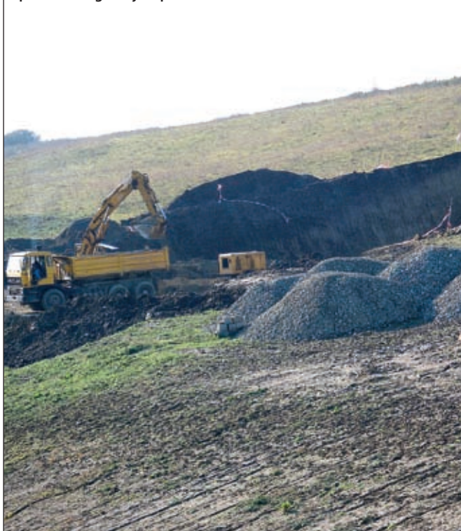
Opatovac – izgradnja crpne stanice
