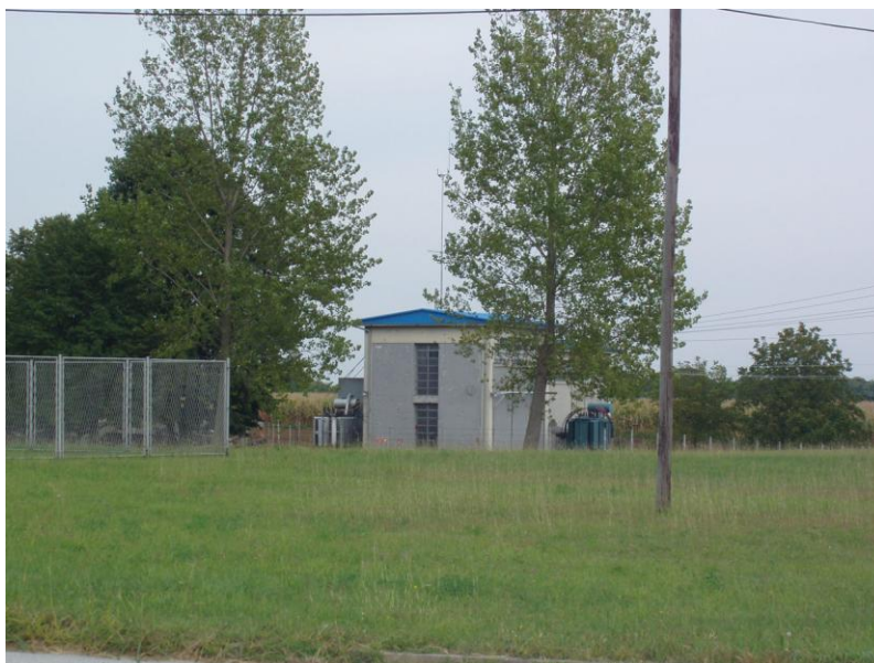
TS 35/10 kV Opatovac
