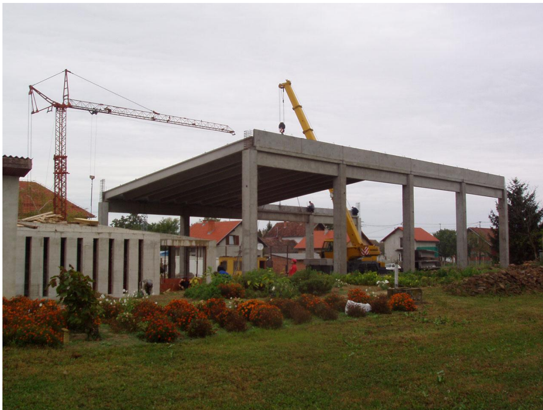
Školska-sportska dvorana u izgradnji
