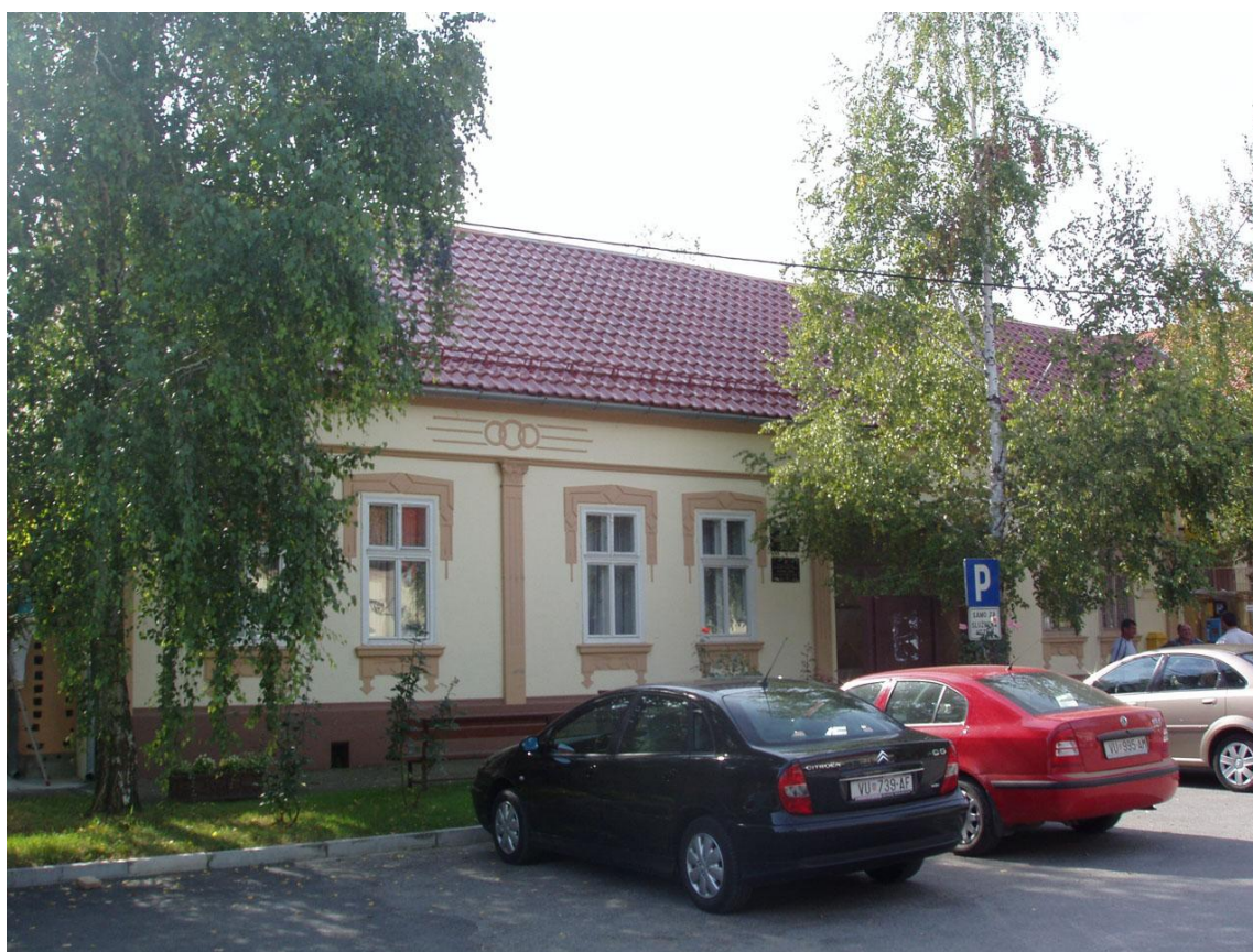
Zgrada općine Lovas
